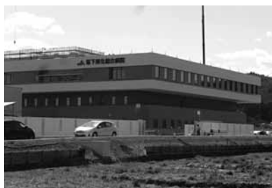
建築中の坂下厚生総合病院
