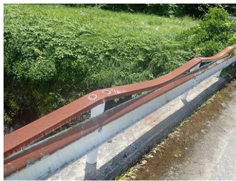
写真-8 防護柵の変形
