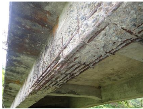
写真-4 RC橋 主桁の鉄筋露出
