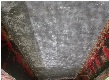
写真-5 RC橋 床版ひびわれ
