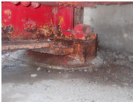
写真-3 支承の腐食
