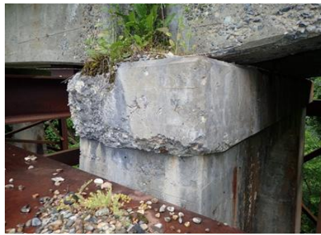
写真-6 下部工のスケーリング
