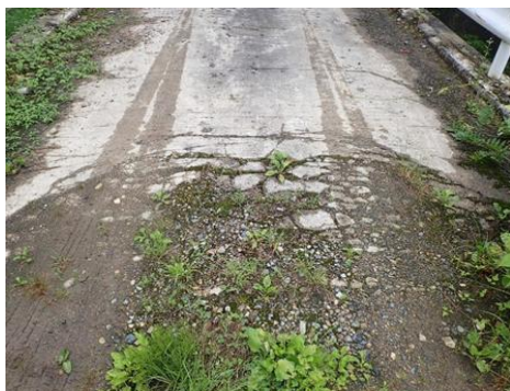
写真-7 舗装のひびわれ
