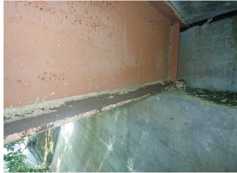
写真-2 鋼桁の塗装劣化
