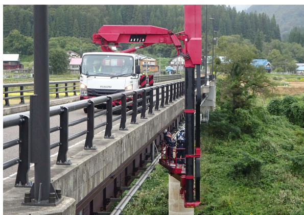
橋梁点検車での点検
