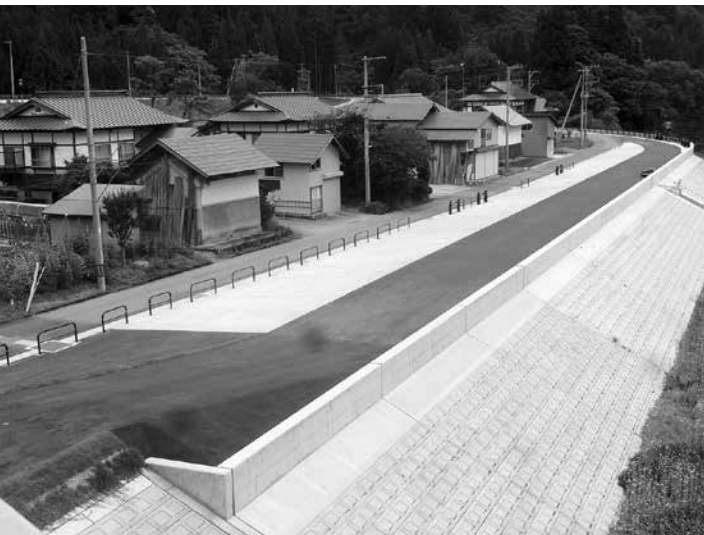
只見川河川整備事業計画は13地区17箇所です 事業完了地区は未だ2地区です 築堤で暫定完成した湯倉地区
