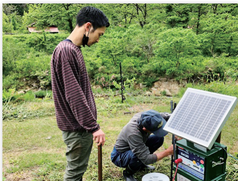
電気柵の設置
