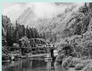
②第四只見川橋梁 （R252水沼橋から只見川上流を望む）
