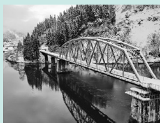
③第五只見川橋梁 （R252西谷・牧ノ戸付近から望む）
