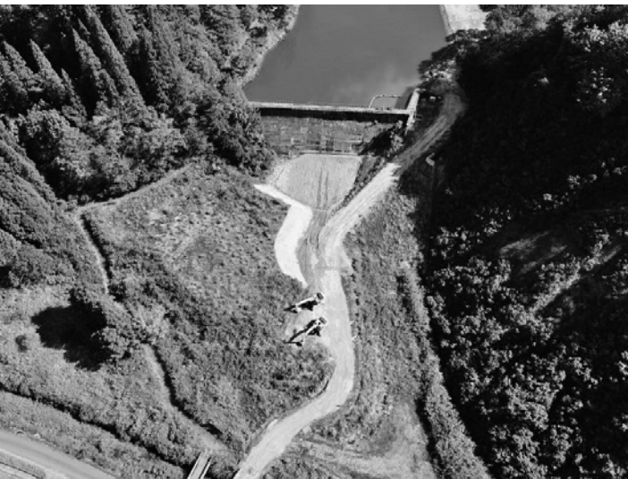
大岐調整池盛土状況(9月撮影：山入) 約23万㎡の盛土を搬入する予定です
