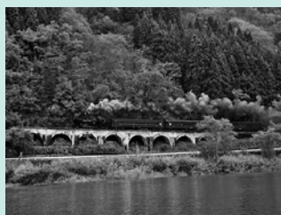
①細越（眼鏡橋）橋梁 （R252水沼橋下流、只見川から望む）
