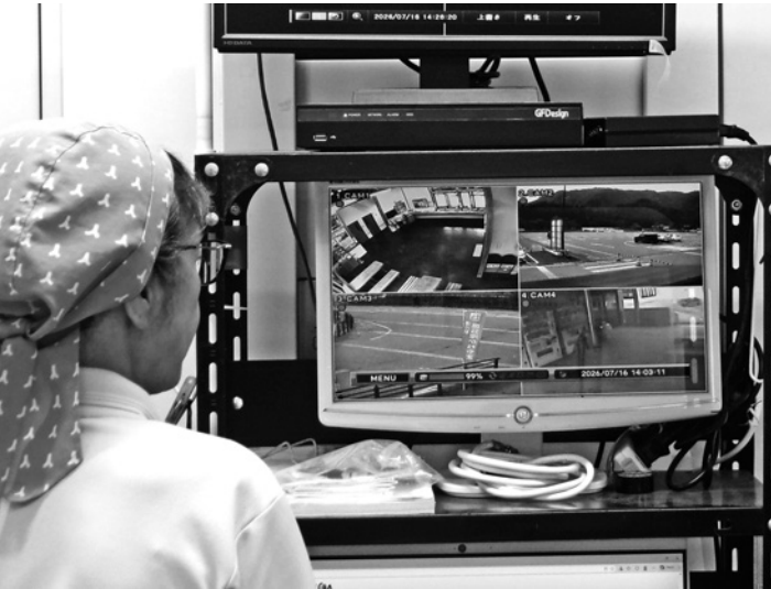
道の駅「奥会津かねやま」施設内に設置の防犯カメラ監視モニター（事務室）
