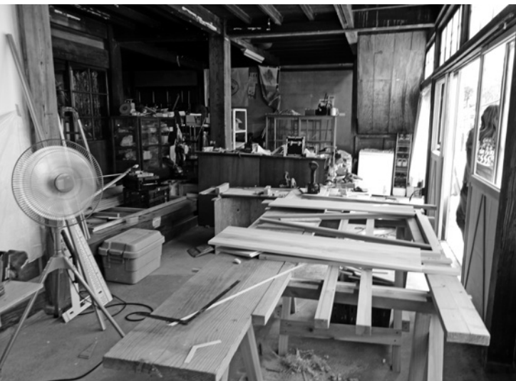
会津川口駅前商店街空き店舗 お土産物売り場として改装中 オープンが楽しみです
