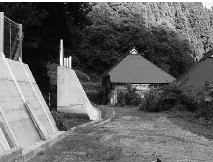
県工事の急傾斜地崩壊防止対策工事 構造物(擁壁)の用地は永久借地で賃借料無料 固定資産税は土地所有者に(玉梨地区)
