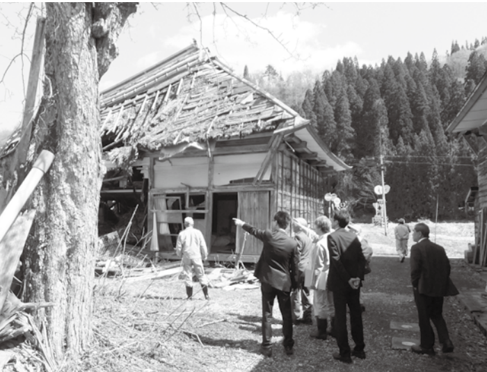
解体済の特定空き家(上横田地区) 写真は解体前特別委員会での現地視察 (平成29年5月)
