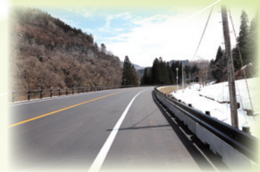
完成した国道252号
