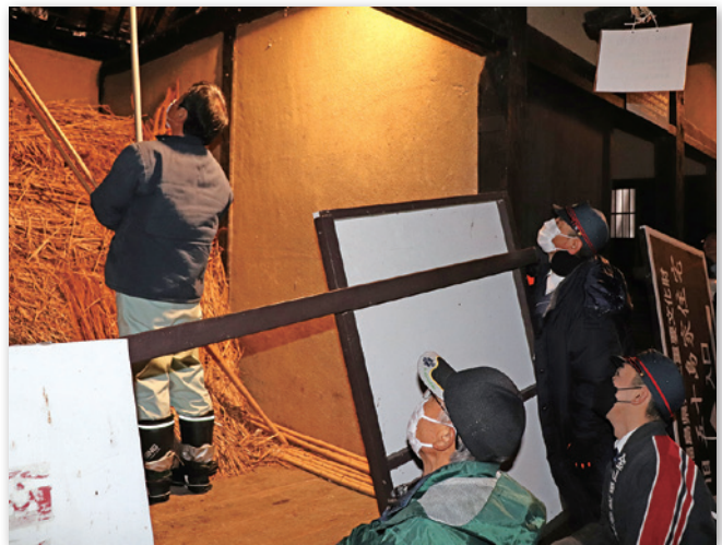
火災報知器が正常に鳴るか確認しました
