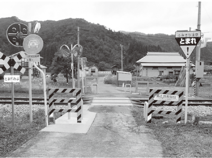
会津越川駅近くの第2越川踏切 線路内幅員が狭く通行車両規制があります
